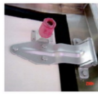
Door Stopper and S/S Door Frame
